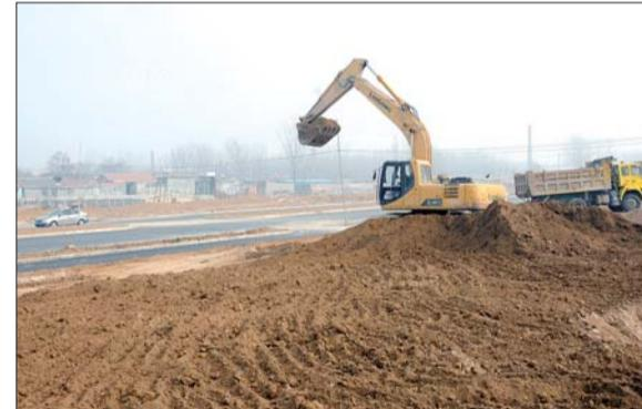
长城路西段,施工人员正在进行道路排水管道的挖掘建设。
