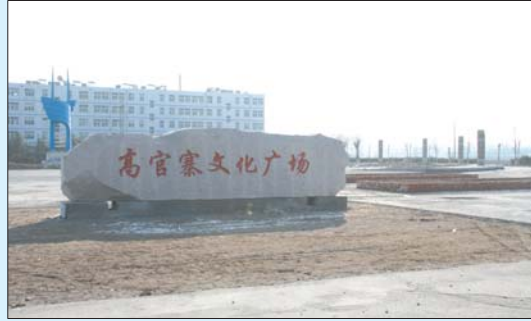
正在建设中的高官寨文化广场
