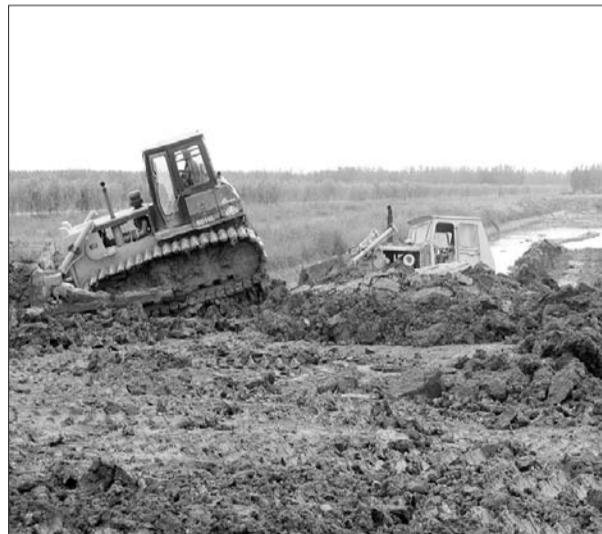
采煤塌陷地整治施工现场。
