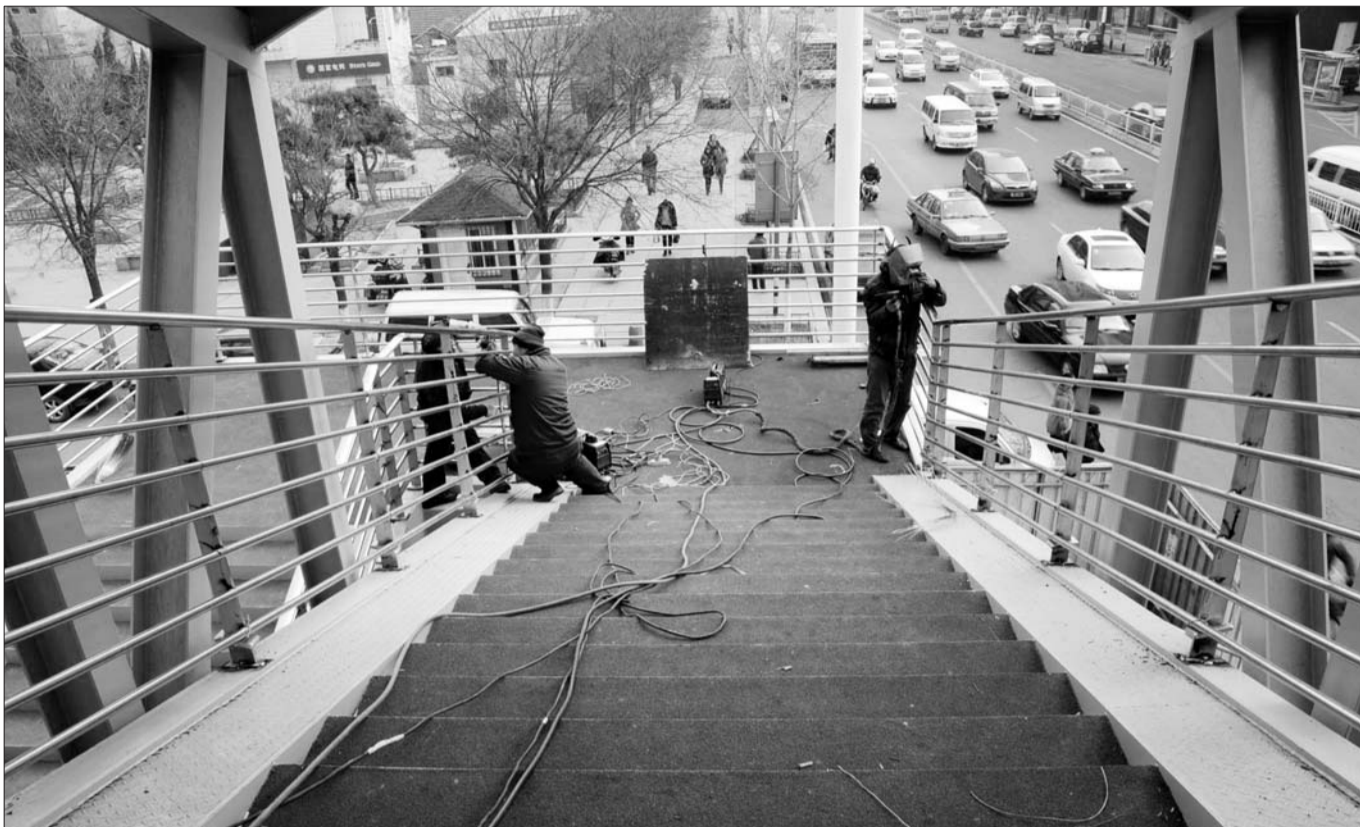
23日,南大街振华购物中心过街天桥主体已完工,工人们正在进行最后的扶手栏焊接工作。本报记者 李泊静 摄
