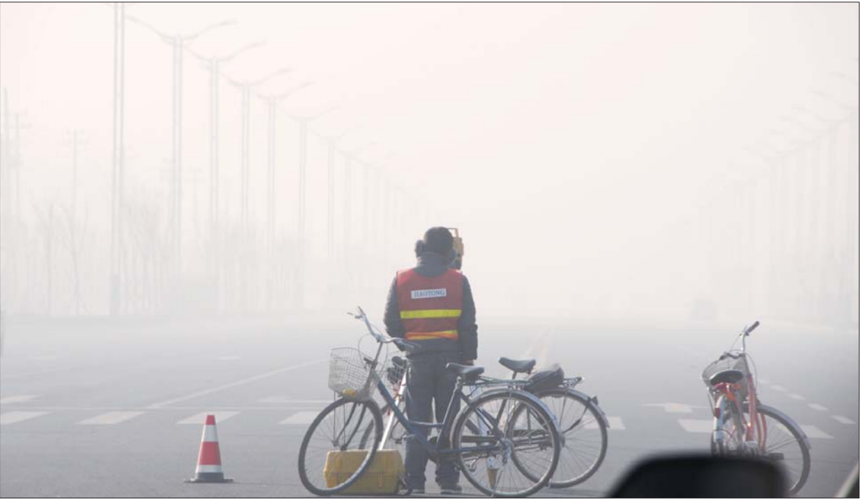
12月23日,在中傲大道上,测量人员正在雾霾中进行测绘,受雾霾影响能见度降低,不得不缩短测量距离。 本报记者 马志勇 摄
