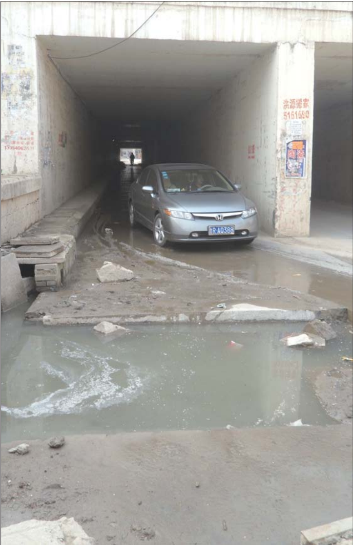
►下水道的盖板被掀走,污水四溢。 本报记者 张建丽 摄
