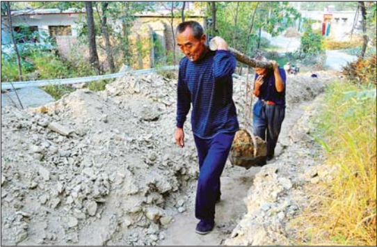
为防止水管冬天被冻,村民往壕沟里抬土做铺垫。
