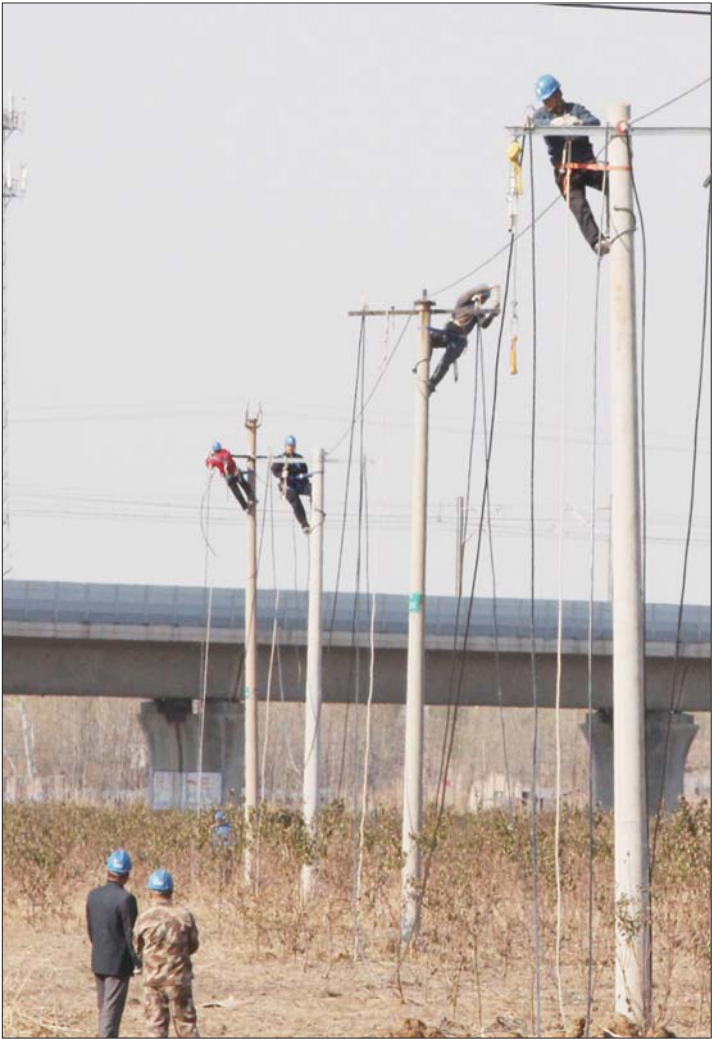
供电员工冒严寒对10千伏宣农线进行升级改造。 王保华 宋媛媛
