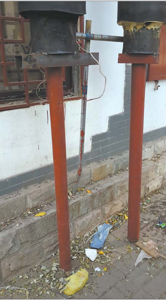
供暖管道就差接入换热站了。
