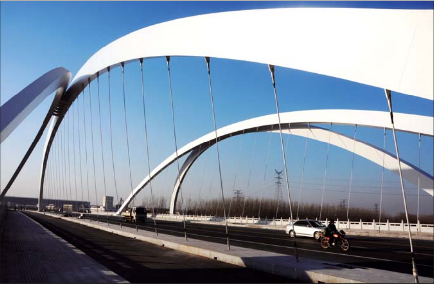
天衢东路减河桥成为连接经济技术开发区与高铁新区的新通途。 本报记者 马志勇 摄
