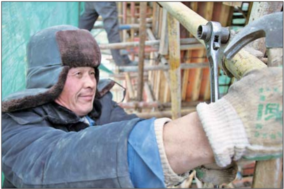
12月18日,孙士存正在冒雪安装脚手架。
