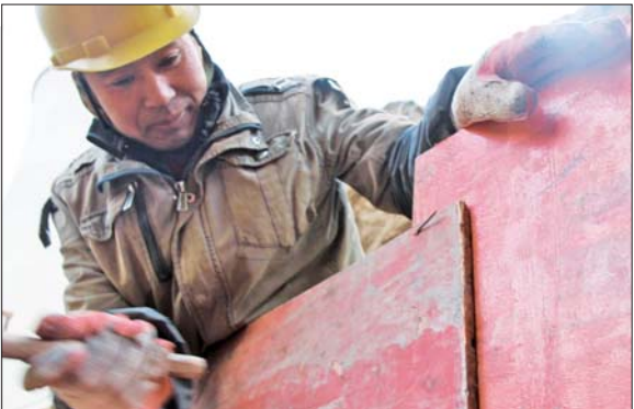
威建二公司的施工人员正在安装架子板。
