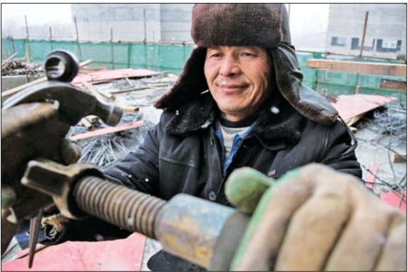
孙士存正在加固工地上的攀爬楼梯。
