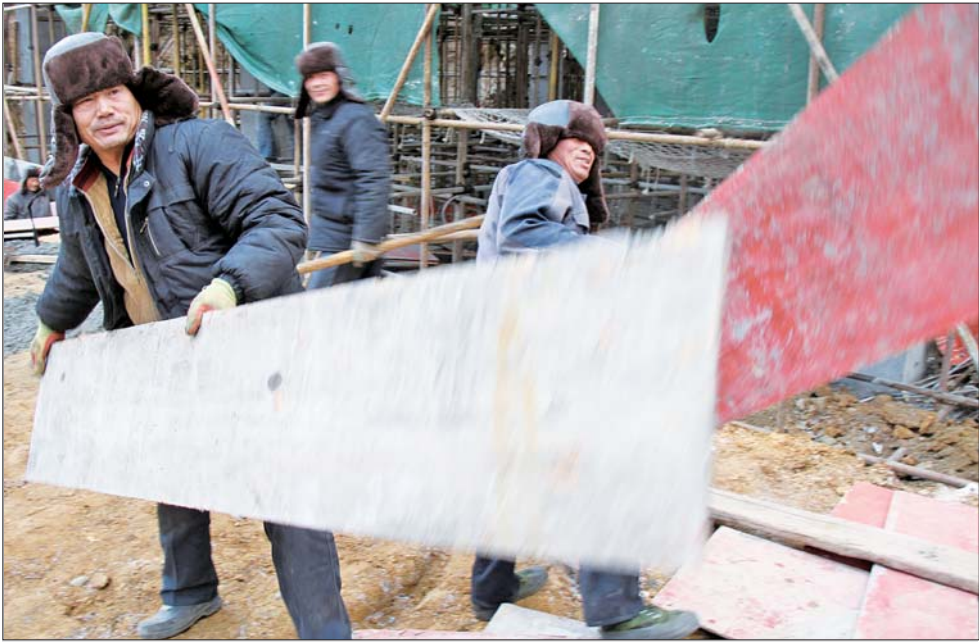
到年底了,威建二公司的施工人员正在抓紧时间施工。
