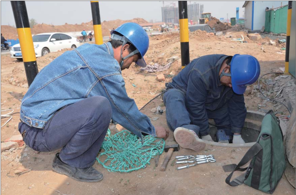
淄博供电公司临淄供电中心工作人员为辖区电缆检修井安装防坠网。 本报通讯员 毕乃文 摄
