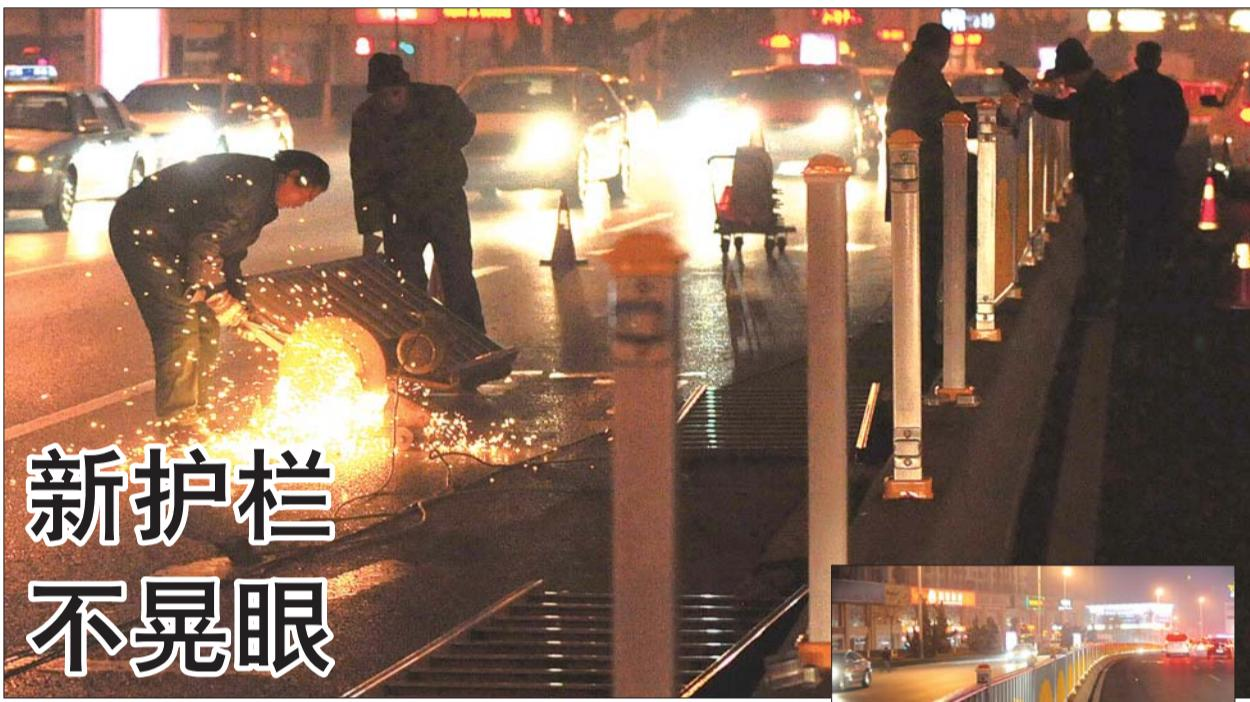
5日晚,经十路燕山立交桥西侧,济南交警派出的施工人员正在换装挡光中央护栏。这种护栏的特点是能够利用一个特殊的角度,阻挡相向汽车直射的灯光,防止司机被晃眼看不见。据施工人员介绍,目前的换装属于实验性质,换装路段大约300米。
