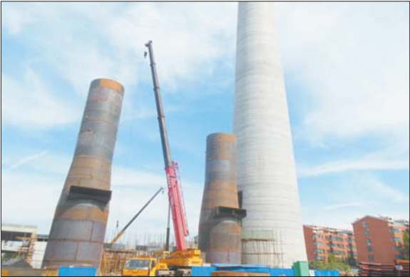
东新热电厂新安装的热水锅炉。 本报记者 蒋龙龙 摄
