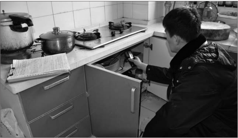
安检员正在对居民家中的燃气具进行检测，
