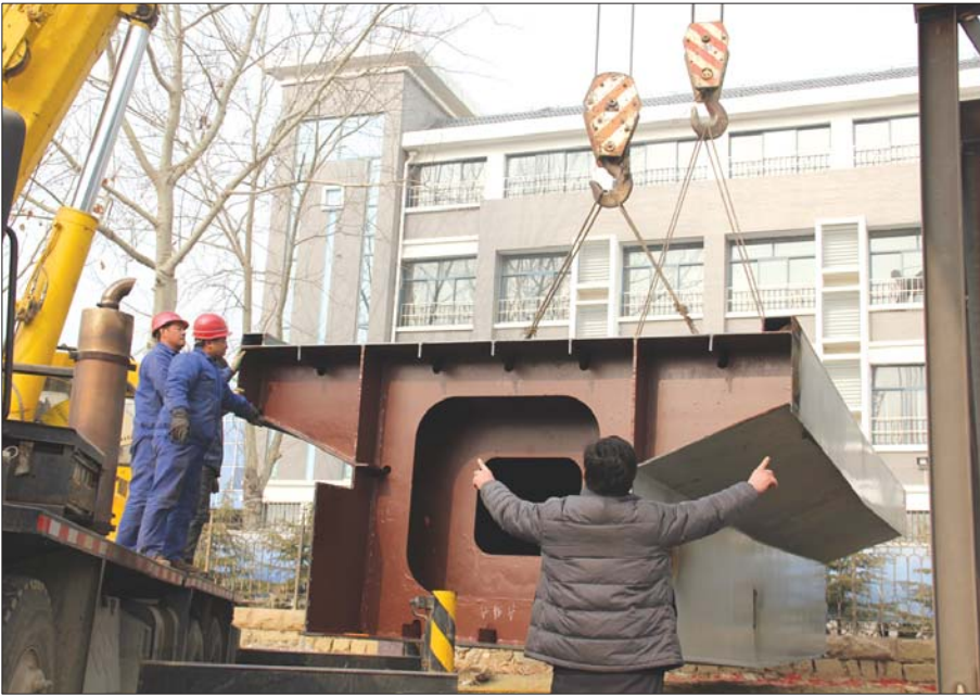
工作人员用手势指挥两个吊车同时安装桥梁。
