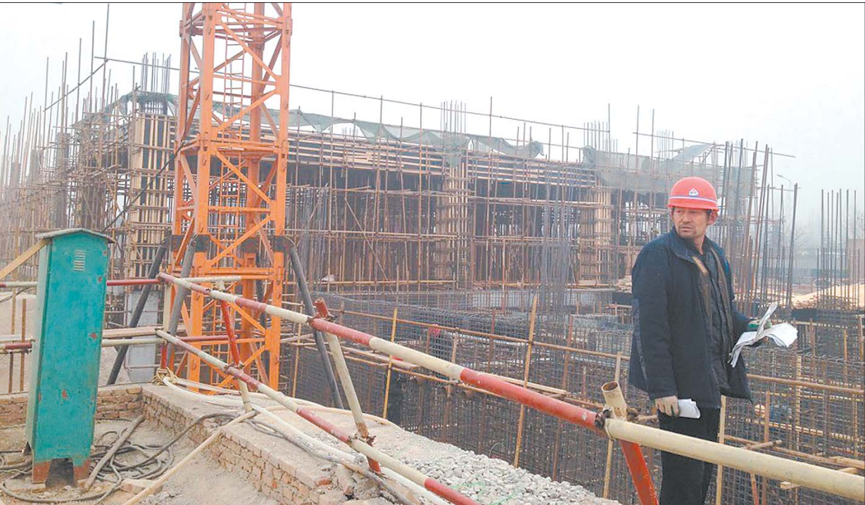
章丘客运总站已施工至地上一层。 本报记者 赵克 摄
