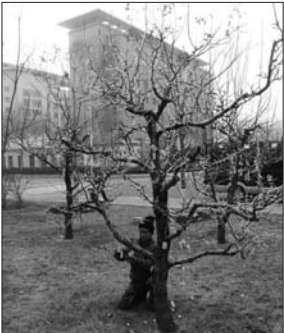
工作人员在新滨公园悬挂LED灯串。
