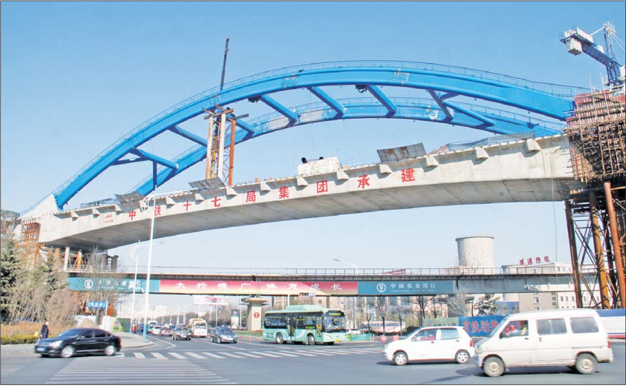
▲22日,青荣城际铁路跨青岛南路特大桥上两端的桥拱已相连,工作人员正在进行焊接工作。 记者 王震 摄
