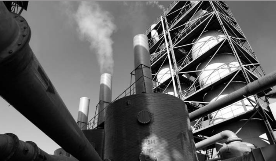
废气通过臭气喷淋洗涤塔处理后可达标排放(资料片)。 本报记者 王鑫 摄
