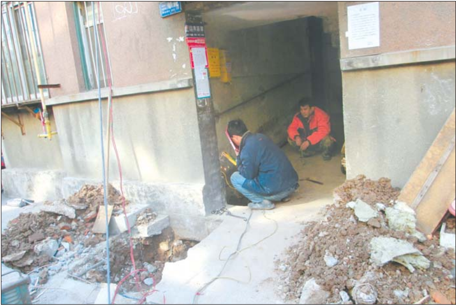
工作人员正在把破损的管道挖出,换成新的管道。 本报记者 蒋龙龙 摄
