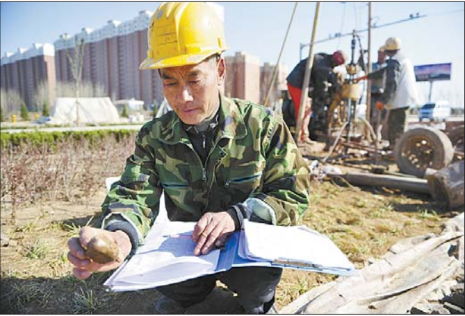
20日,在济南刘长山路延长线玉符河附近的绿化带中,施工人员正在对岩芯进行分析记录。
