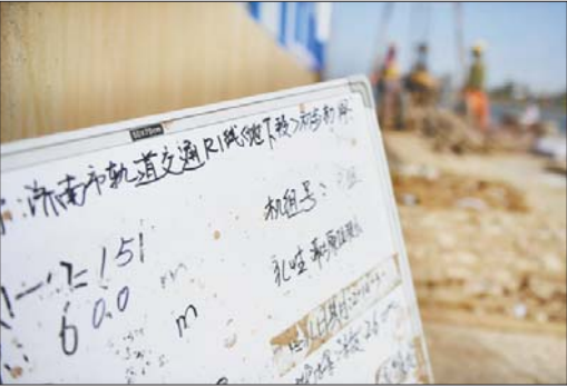
勘探工地上的公告板,记录着钻探的进度。
