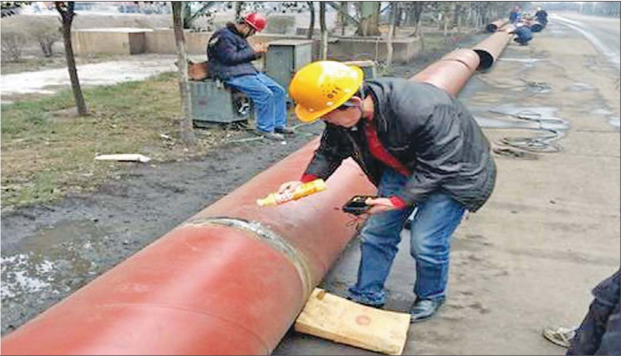
东联供水二期施工现场。
