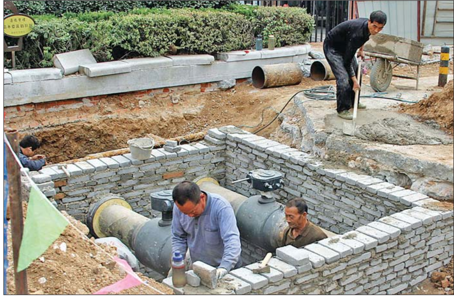
去年黄金时代部分供暖管道进行了改造。(资料片)
