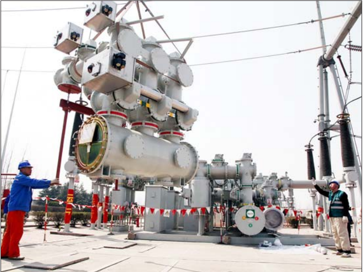
▲吊装220千伏组合电器 精细进行二次接线▶
