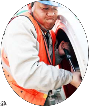
校紧220千伏 母线触头螺栓▶
