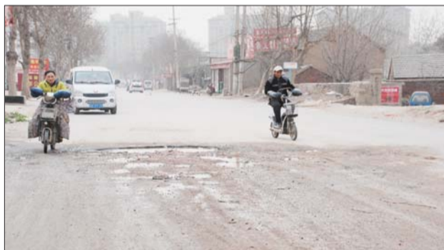
破损的路面变得坑坑洼洼,一遇到下雨就会积水。本报记者 李婷婷 摄
