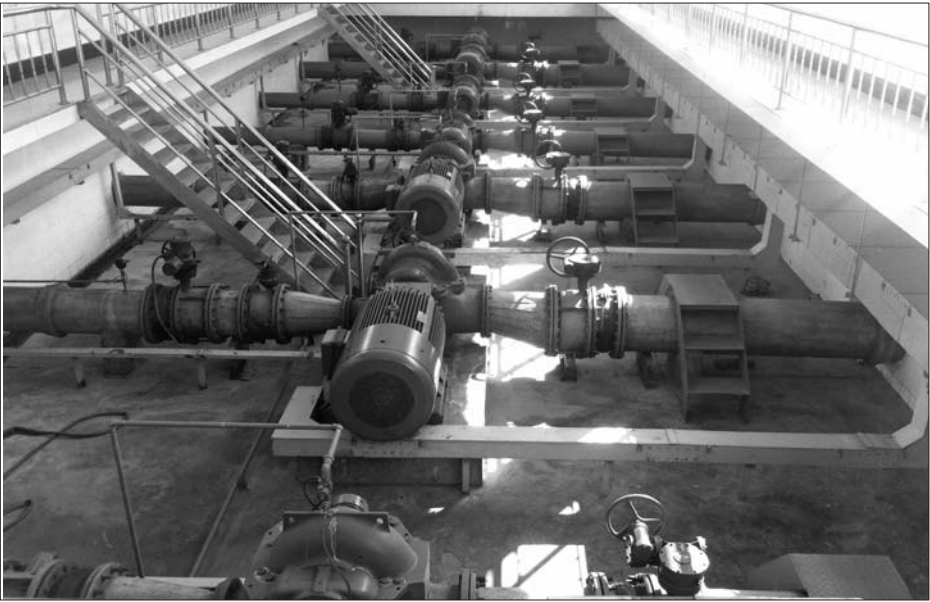
自来水消毒后通过水厂内的加压泵进入城区供水管网流入千家万户。
