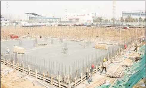
一层层顶模板支设和钢筋绑扎。23日,工人正在进行地下
