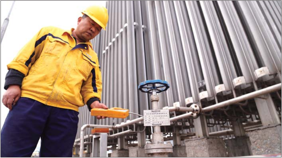
新奥燃气储气站的工作人员随时检查管道密封情况,保证安全运输。 本报记者 韩逸 摄
