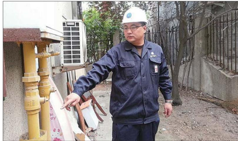
16日,检查人员发现,济南饮虎池街灰口铸铁管被旁边的违章建筑压盖,一旦断裂泄漏,极易发生爆炸。本报记者 孟敏 摄影
