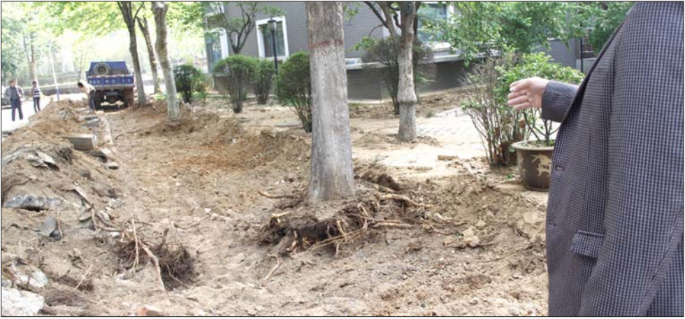
鲁能康桥小区12号楼旁边的人行道已经被挖开,实习生 王乾宇 摄
