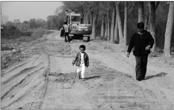
施工单位正在恢复受损道路。 本报记者 王小会 摄
