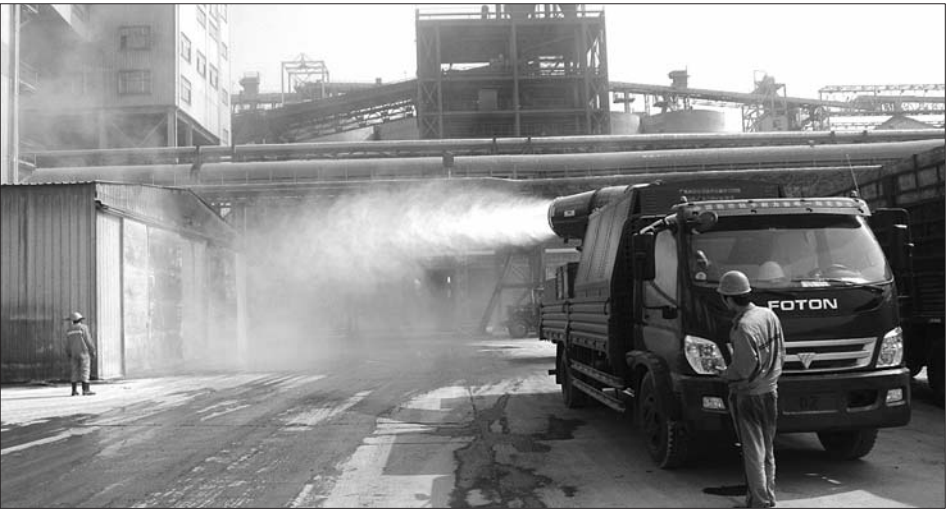
一公司的射雾车正在对木薯干散发罐进行喷雾降尘。
