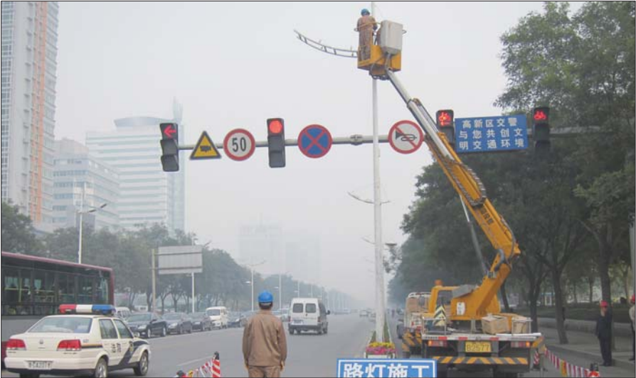
施工人员正在对路灯进行检修。 本报通讯员 董晨 摄
