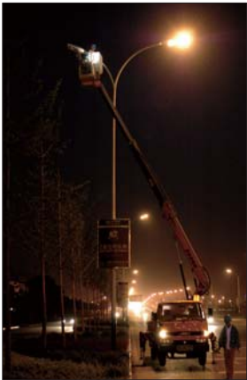
路灯出现故障,工人第一时间进行抢修。 本报通讯员 董晨 摄
