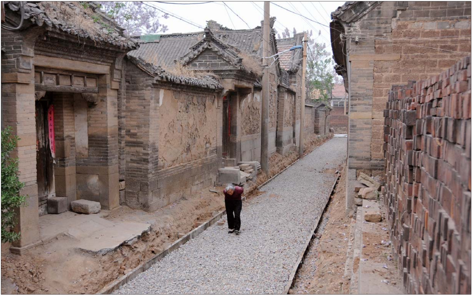
▲李家疃村的南北大街,路面正在进行保护性维修。
