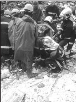
黄岛挡土墙倒塌事故救援现场。
