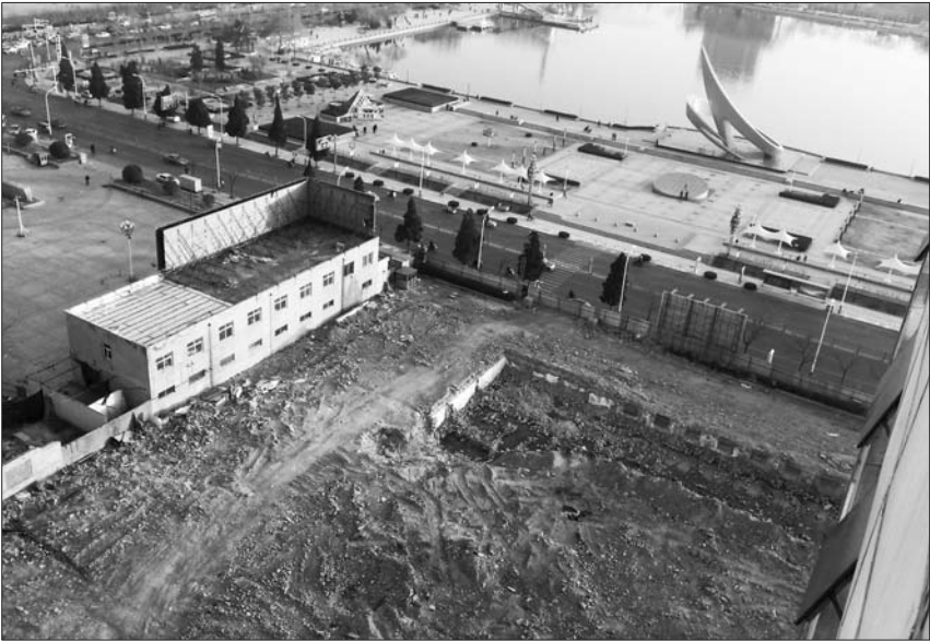
1月6日,德州市人民医院门诊楼已经拆迁完毕,等待开工建设。 本报记者 马志勇 摄
