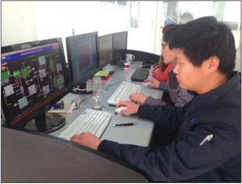
工作人员实时监控处理厂内部设施。
