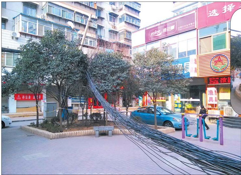
▲路灯杆被压断,上面“爬”满近50根无名线缆。
