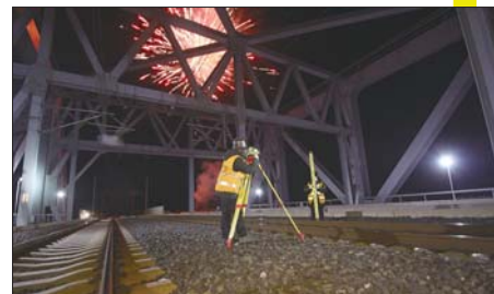
烟花下，济南西工务段工人坚守岗位。
