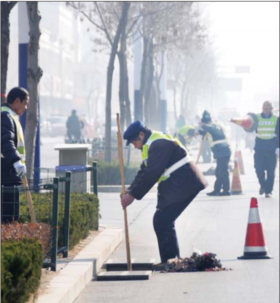
开工早 3月1日,三八路上,市政工作人员早开工,清理下水道,为多雨季节做准备。 本报记者 马志勇 摄
