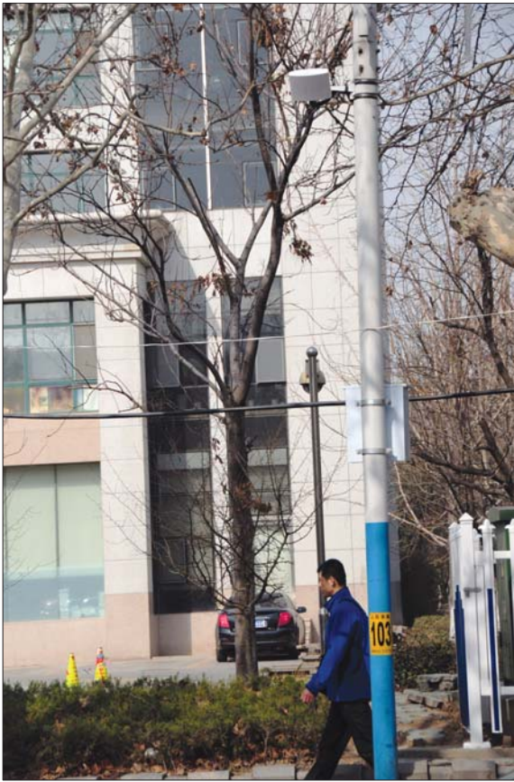
通过地上微波探测器，可随时收集道路信息。 实习生 李洋 摄
