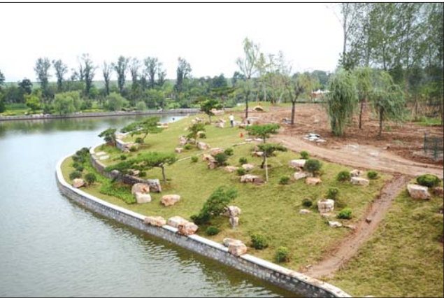
建设中的东周河滨河湿地公园。
