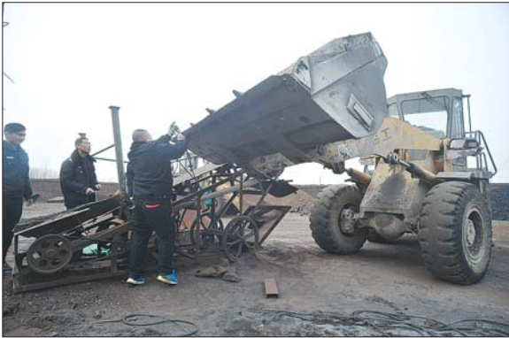
查处的上料机被拆除运走。
