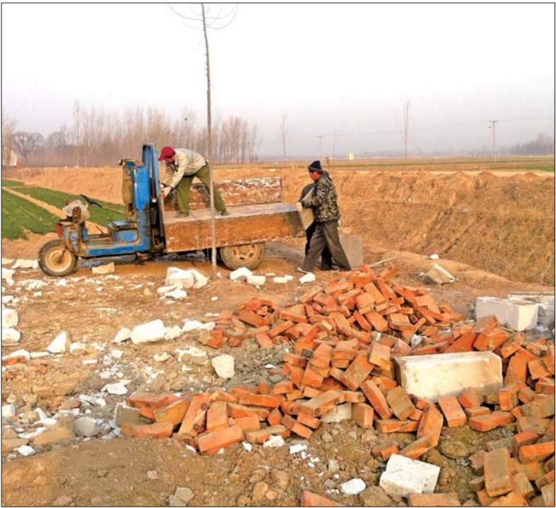
收到拆除令后,盖房者将房子拆除清理。 孙集镇综合执法大队提供
