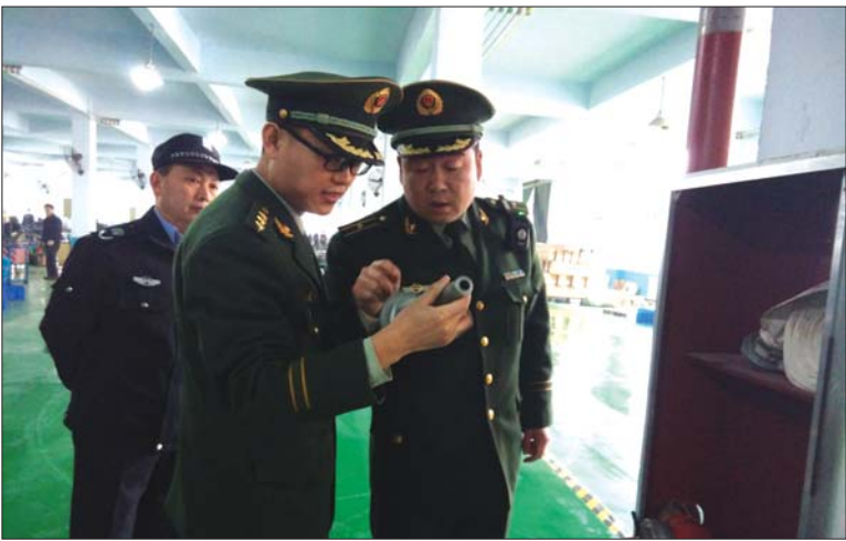
检查人员查看企业消防设施。 本报记者 张伟 摄
