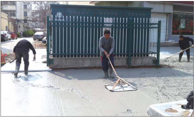
施工人员正在铺设混凝土路基。 本报记者 张召旭 摄
