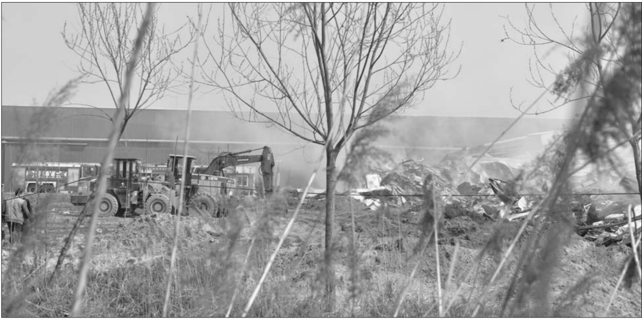
25日下午1点半,惠民县长青木业下属一立方公司西北方向仍有明火。
