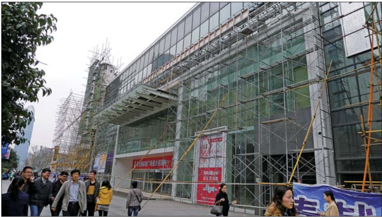
27日，济南泉城路，老百盛大楼正在装修。 本报记者 周青先 摄
