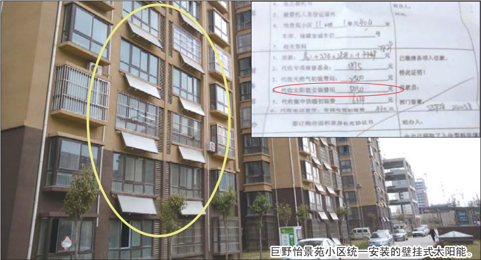
巨野怡景苑小区统一安装的壁挂式太阳能。
