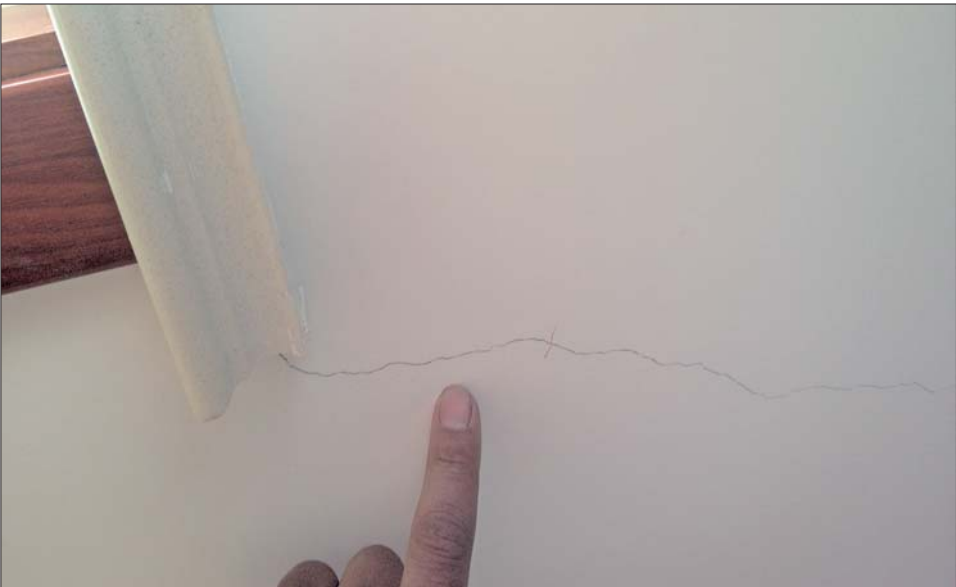
室内墙体出现不少裂缝。
